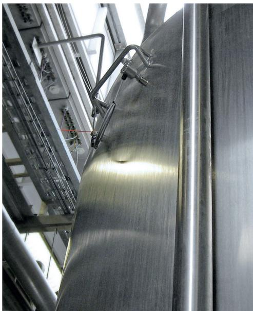
Der *CleverLevel* detektiert den Füllstand im Tank mit überschüssiger Hefe
