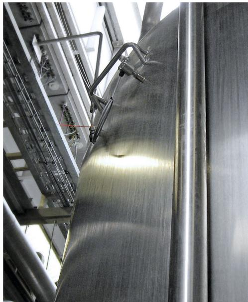
Détecteur de niveau *CleverLevel* utilisé pour détecter le niveau de remplissage d'un levurier de stockage.
